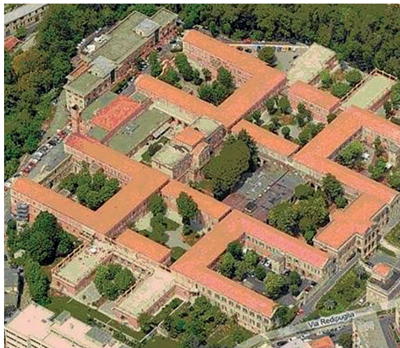
La struttura dell'ex Ospedale Psichiatrico di Genova Quarto
